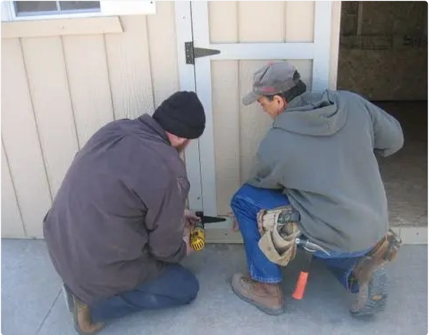
Install the door
