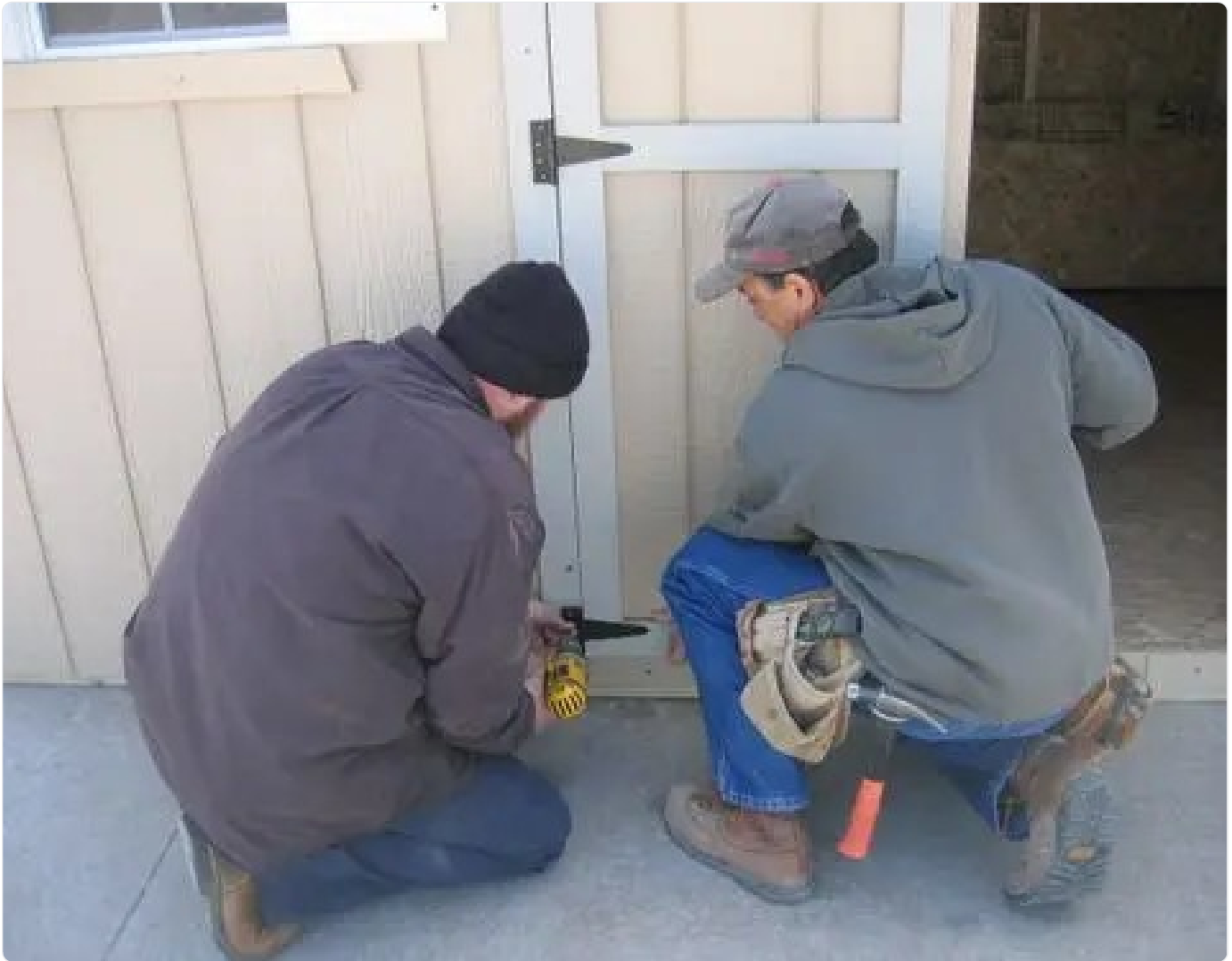
Install the door
